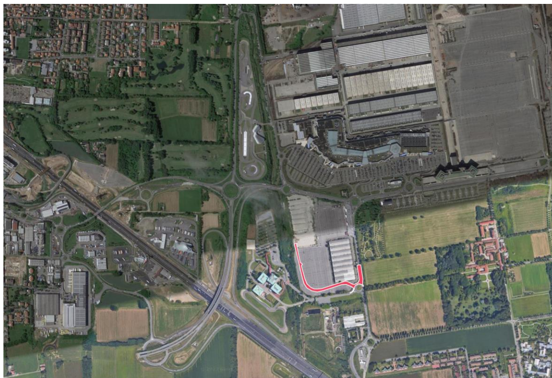
Figura 2 Posizionamento dell'area di progetto N8 su base ortofotografica (Google Satellite).
