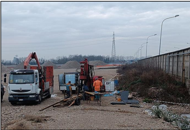
Fig. 4 – Piezometro Pz2: fase di allestimento a sinistra e chiusino a destra.
