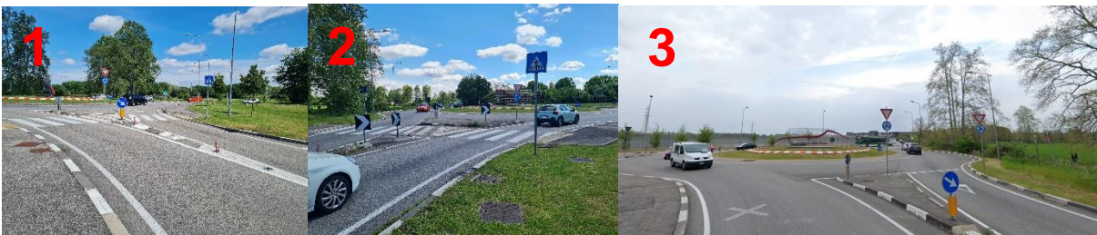
Infrastruttura stato di fatto
